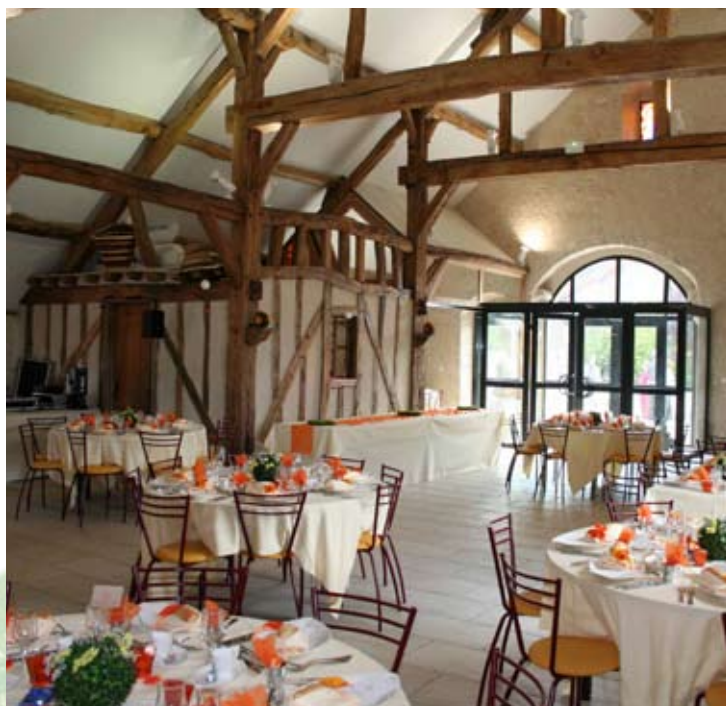
CHARPENTE DU XIV ème ET SES MURS EN PIERRES APPARENTES
